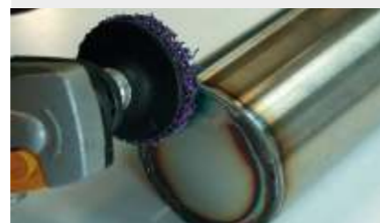
Czyszczenie zgrzewów i przebarwień
