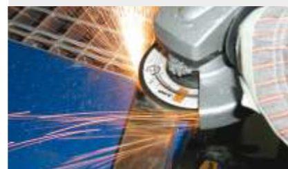
Usuwanie nadlewów i zendry
