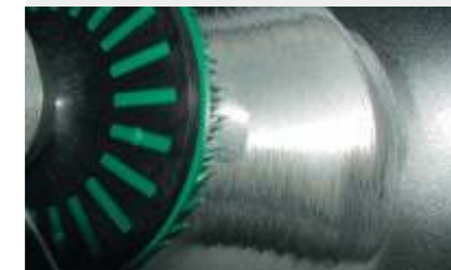
Usuwanie powłok malarskich
