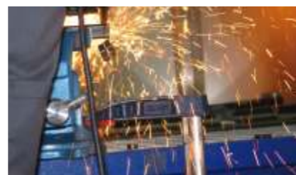
Cięcie profili zamkniętych
